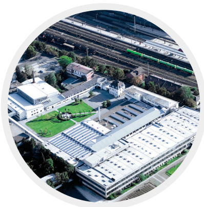
Wieland Holding GmbH Wieland Electric GmbH WERK I Brennerstraße 10–14, D-96052 Bamberg
