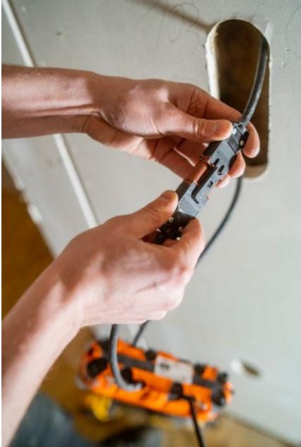
*Farbliche Codierungen des Wieland PREFAB® Installationssystems sorgen dafür, dass ein Fehlstecken sicher vermieden wird. (Bild: Wieland Electric)*
