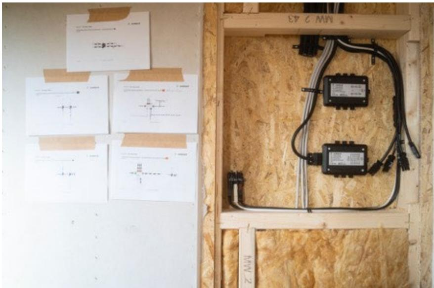
*Je mehr Arbeitsschritte bereits in den Produktionshallen ausgeführt werden, desto leichter wird die Arbeit für die Monteure auf der Baustelle – dies gilt auch für die Elektroinstallation. Hier setzt WOLF auf die vorgefertigten, steckbaren PREFAB Lösungen von Wieland Electric. (Bild: Wieland Electric)*
