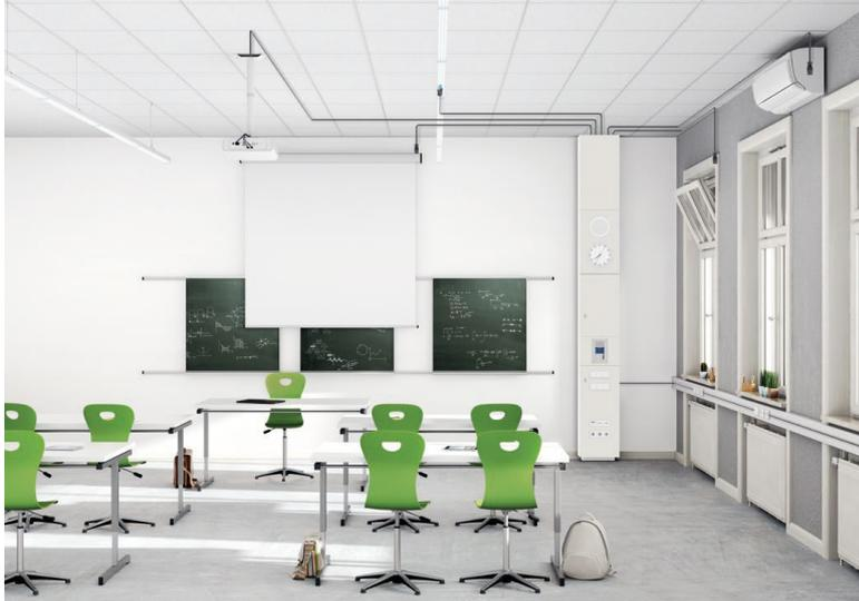
*Durch die dezentrale Installation im Klassenzimmer werden Leitungswege deutlich kürzer, was Material, Zeit und Geld spart. (Foto: Wieland Electric)*
