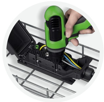
Einlegen der Flachleitung und schließen des Gehäusebodens
