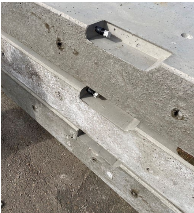
Das RST® System von Wieland Electric ermöglicht es, Installationen in vorgefertigte Böden und Wände einzugießen, wodurch diese auf der Baustelle „steckbar“ sind. (Bild: Isolectra BV)
