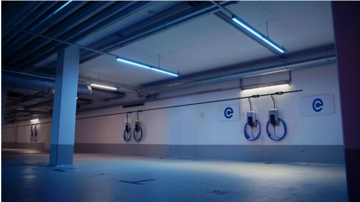
*So geht dezentrale Energieverteilung. Eine Flachleitung kann bis zu 20 Ladestationen bedienen.*
