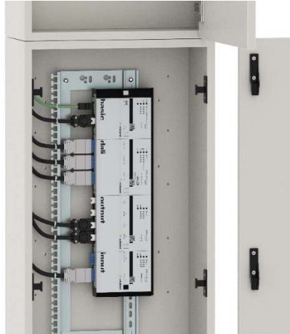
Abbildung 26: Einbauten installieren z. B.: gesis® FLEX
