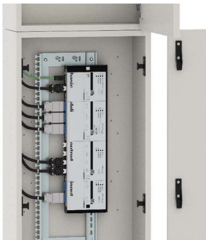
Abbildung 35: Einbauten installieren z. B.: gesis® FLEX
