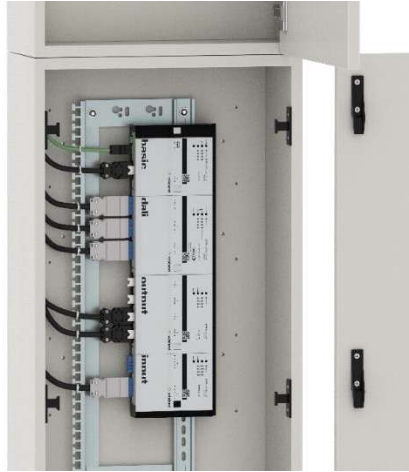
Abbildung 42: Einbauten installieren z. B.: gesis® FLEX
