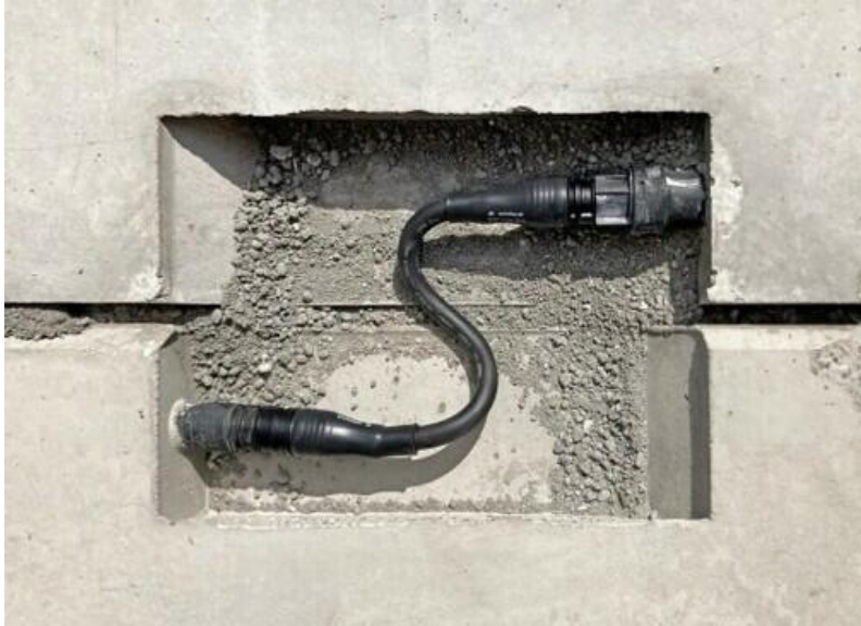
Foto 2 (Modul- und gewerkeübergreifend) Modul- und gewerkeübergreifend gesteckt und verbunden.
