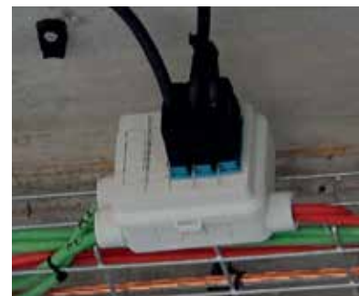
Instalación sobre rejiband
