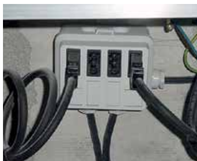
Instalación directa a forjado
